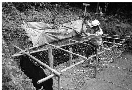
図-7 孔口保護工（ふとん籠）施工状況
