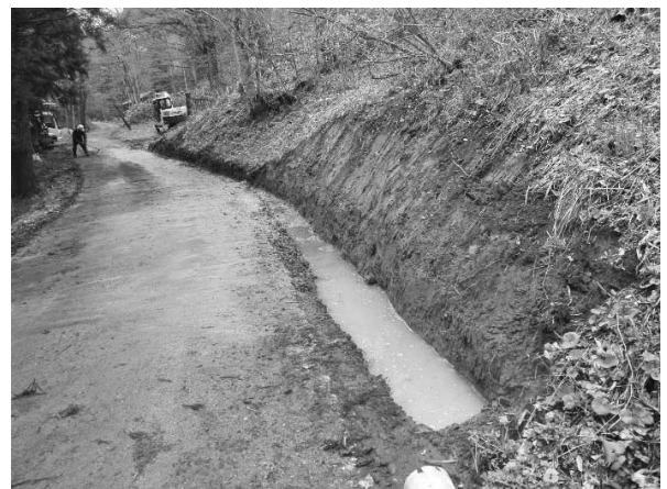
図-1 土側溝設置
