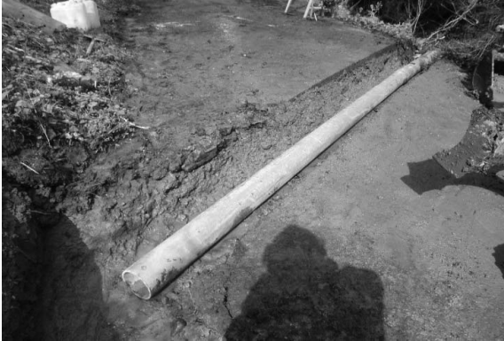
図-2 横断暗渠設置
