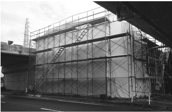
図-3 飛散防止養生足場（県道側より撮影）
