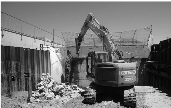
図-4 ブレーカによる取壊し
