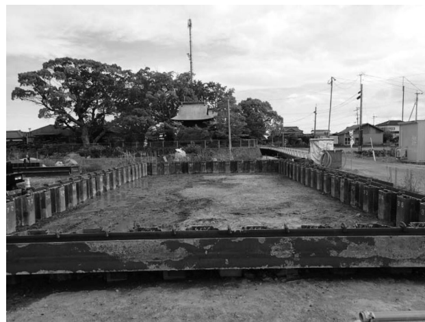
図-4 矢板転倒抑制対策
