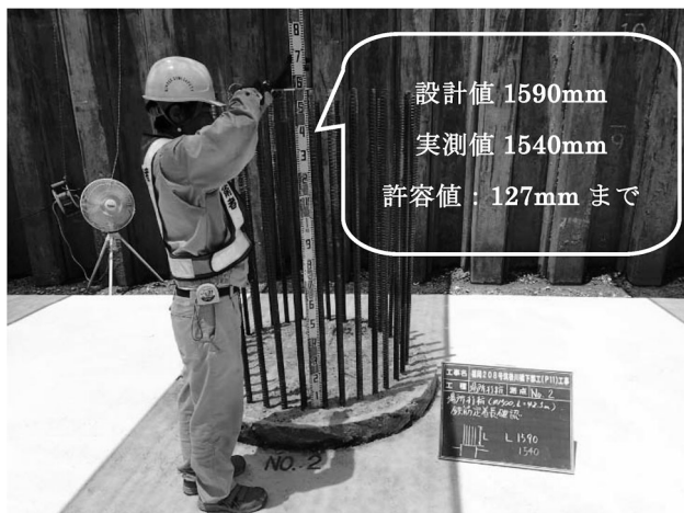
図-3 鉄筋かご定着長管理
