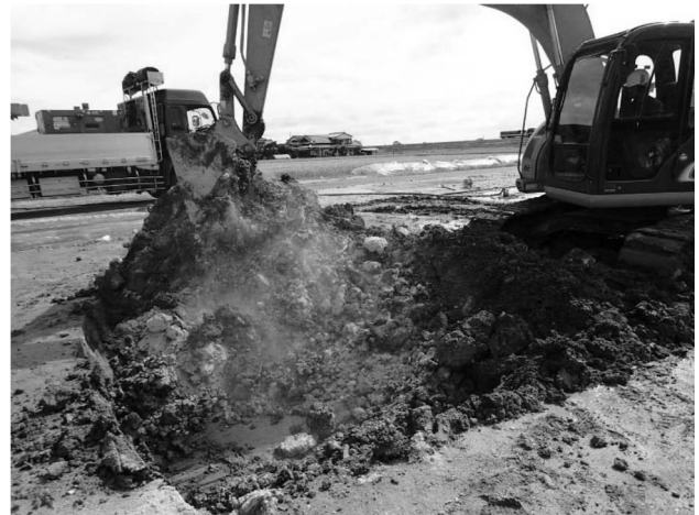
図-1 施工箇所地盤改良状況
