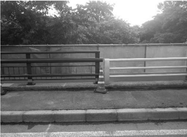
図-3 夕方の道路開放時状況
