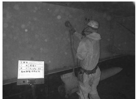
図-1 ケレン作業状況
