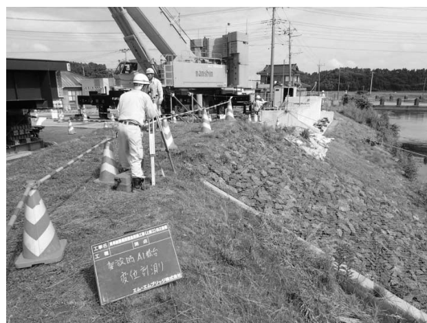
図-3 橋台動態計測
