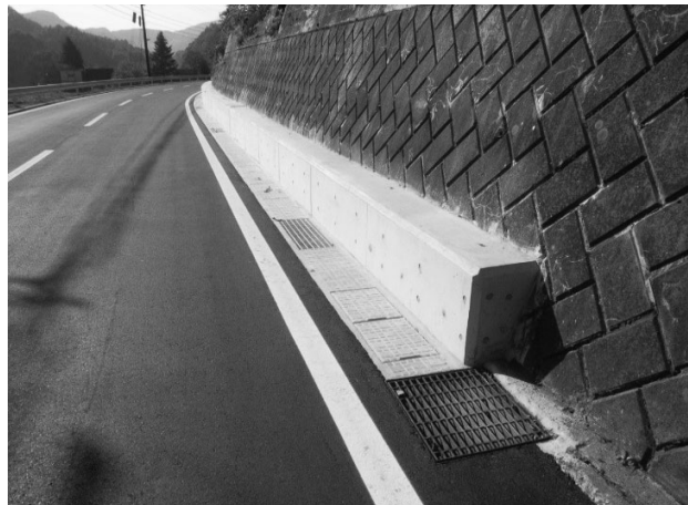
図-5 間詰補強工
