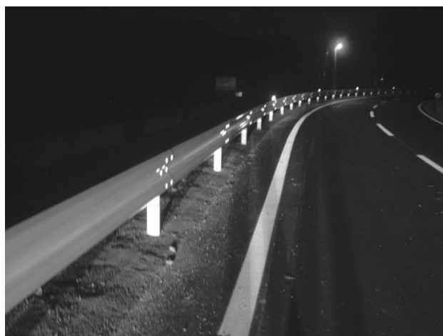
図-6 再帰反射塗装ボルト設置夜間状況
