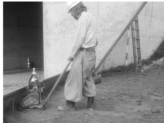
図-7 コンパクトプレート締固め
