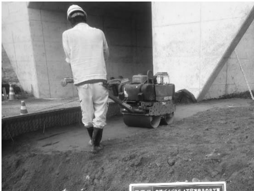
図-4 1 t ローラー締固め
