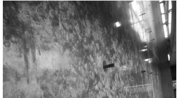
図-4 脱型後のコンクリート表面
