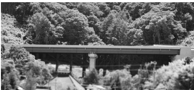
図-1 大沢第二橋
