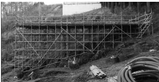
図-3 単管足場による構台設置
