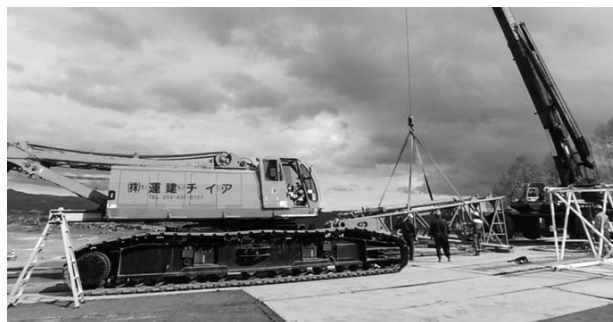
図-5 土工区間のクレーン組立・解体ヤード
