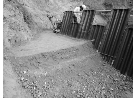
図-7 左岸上流間詰
