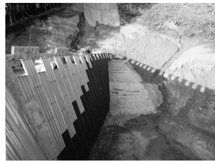
図-8 右岸上流間詰
