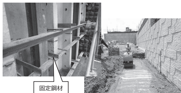
図-5 固定鋼材の設置
