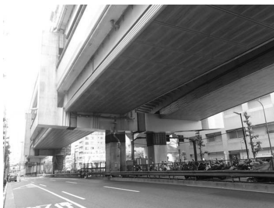
図-1 5号池袋線（板橋工区）
