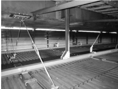
図-2 縦横振れ防止工
