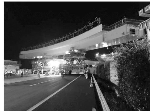
図-2 キャリア架設状況
