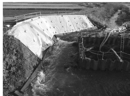
図-6 河川増水時の状況（仮設完了）
