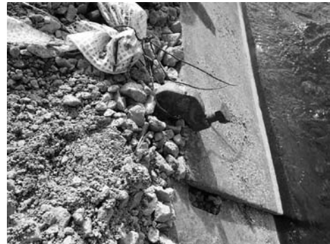
図-4 鉄板の重ね合わせ連結状況
