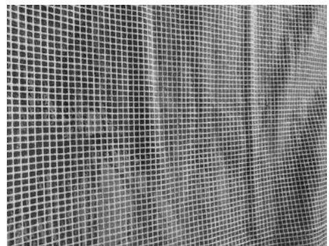
図-5 透明シート（布入り）設置状況
