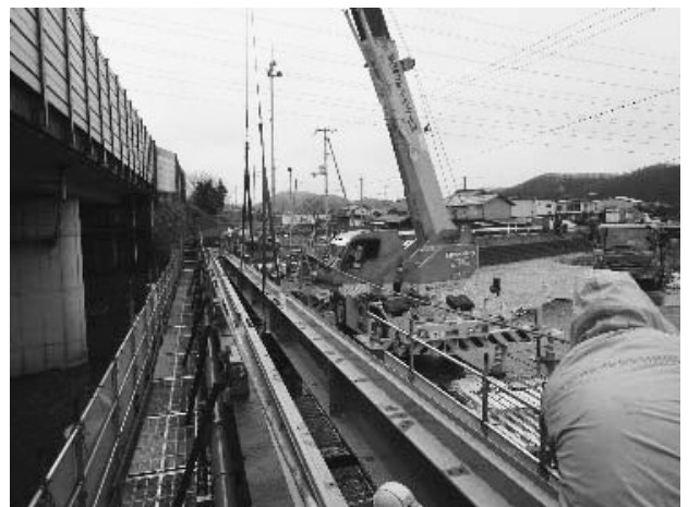
図-3 桁架設状況
