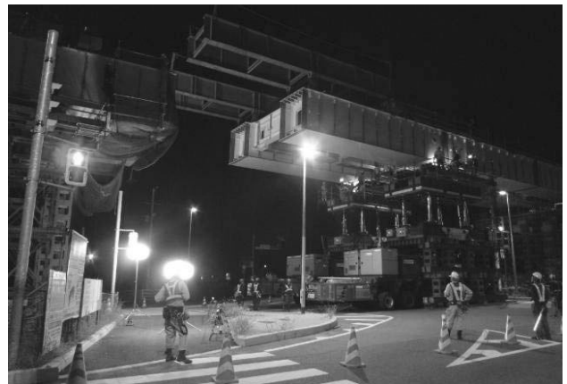
図-5 送り出し架設状況
