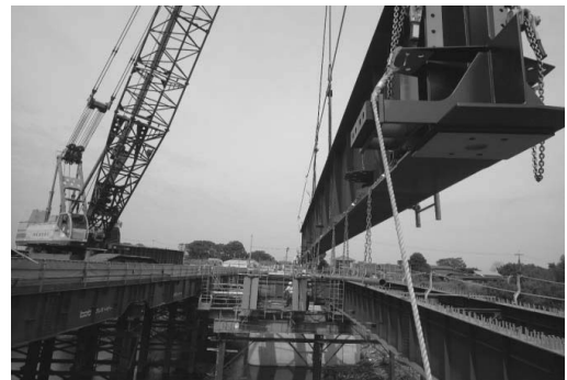
図-2 鋼桁架設状況①
