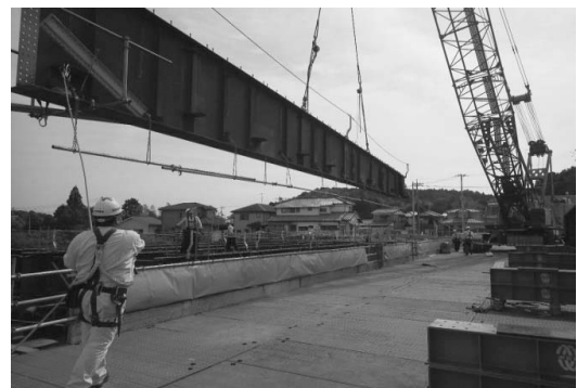
図-3 鋼桁架設状況②
