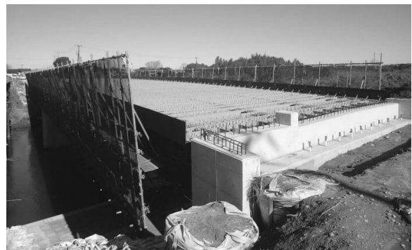
図-6 橋梁全景（架設工事完了後）
