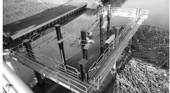
図-5 杭頭処理用可搬式安全通路
