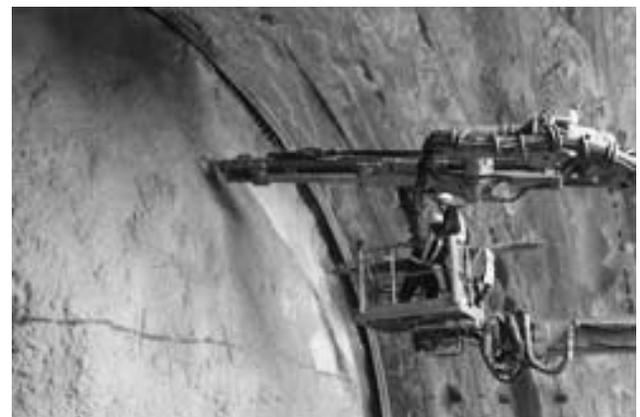
図-2 DRISS 施工状況
