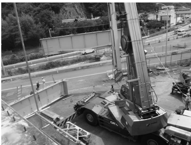
図-2 50t クレーンによる施工状況
