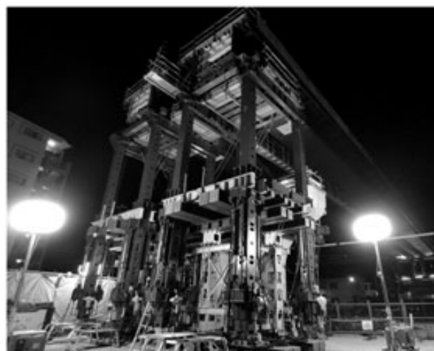
図-4 写真 SHL システム（降下作業状況）
