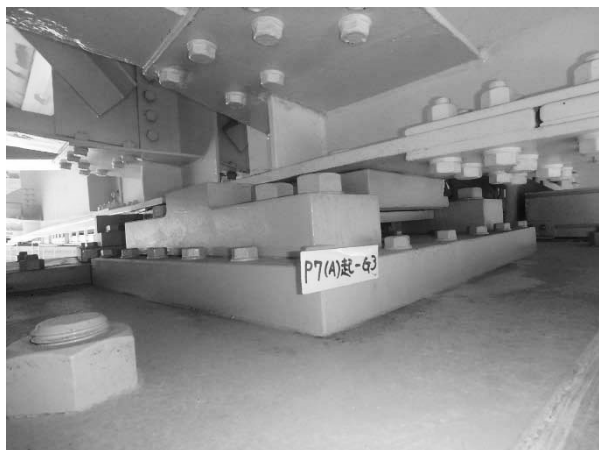
図-3 補修完了写真
