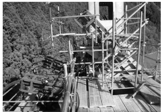
図-6 VSL ジャッキ取付状況
