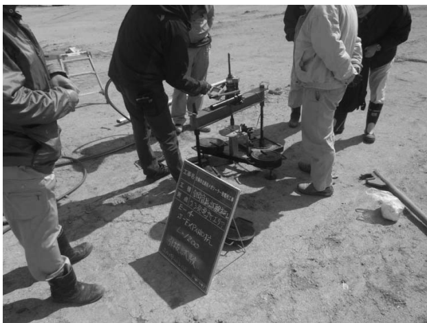
図-3 試験施工状況
