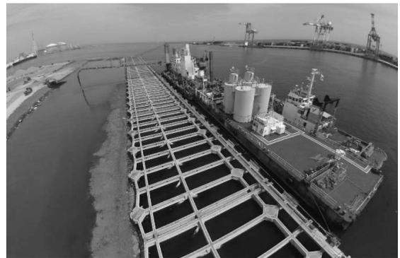
図-5 施工状況（プレミックス船工法）
