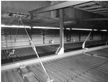
図-2 縦横振れ防止工
