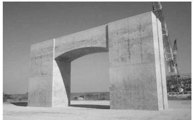
図-5 P10橋脚完成写真
