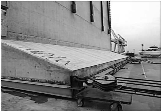
図-9 移動中の3,000トン複合ケーソン
