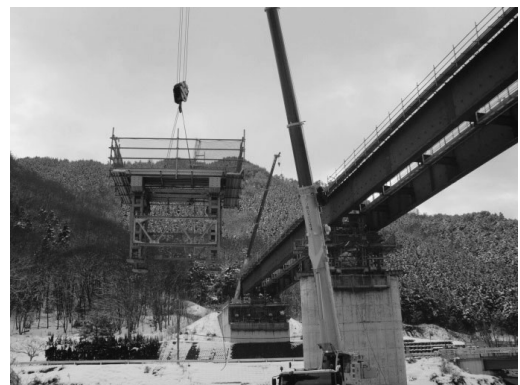
図-3 降下設備設置状況
