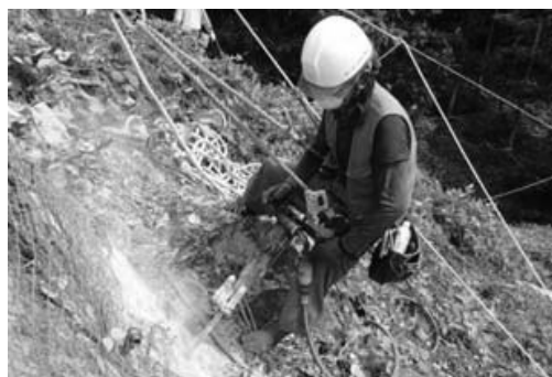
図-3 削岩機による削孔作業状況
