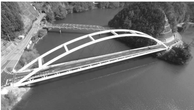
図-1 出合ゆず大橋（手前）と旧出合橋（奥）
