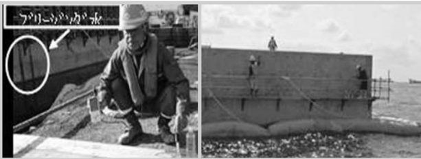
図-9 汚濁防止膜設置・PH測定
