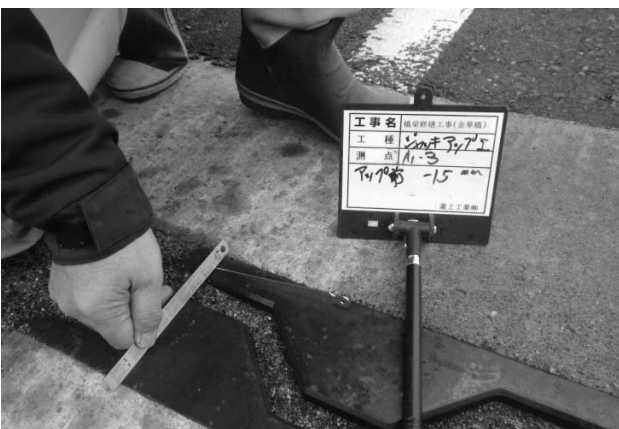
図-11 伸縮装置計測状況
