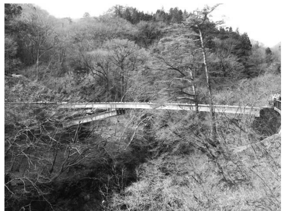
図-5 猿橋全景（鋼桁架設完了時）
