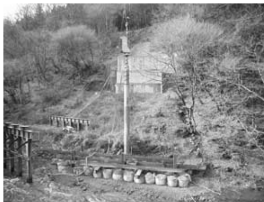
図-4 基礎杭掘削状況
