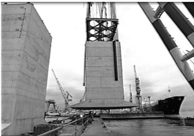
図-1 浜出し中の複合ケーソン
