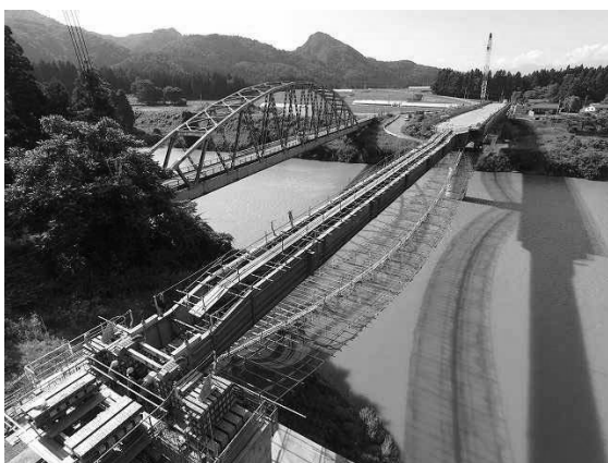
図-1 送り出し状況写真
