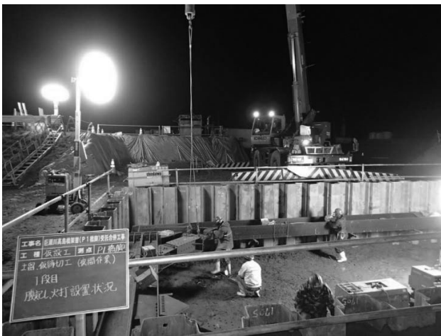
図-2 夜間作業状況
