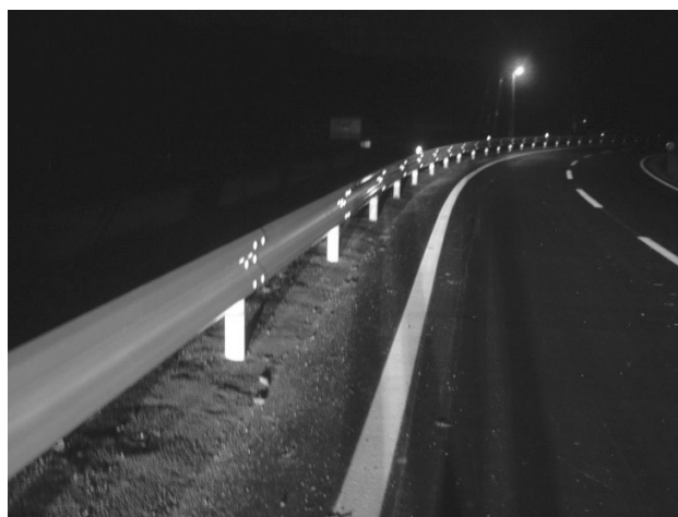
図-6 再帰反射塗装ボルト設置夜間状況
