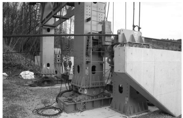
図-9 A2側コンクリート直接基礎
