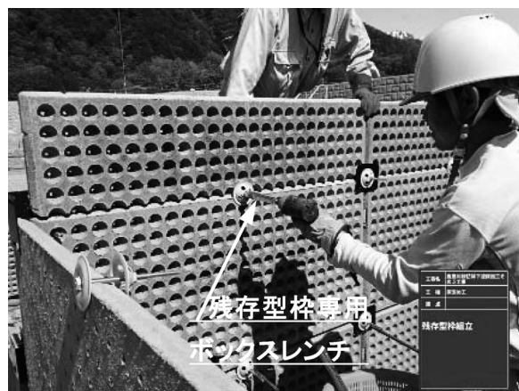
図-13 上段型枠組立状況
