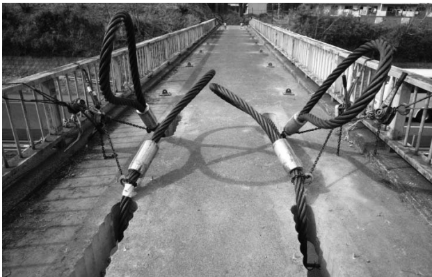
図-4 吊孔削孔とワイヤリング
