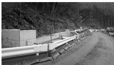
図-6 迂回水路部施工状況
