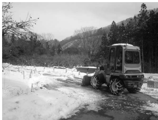
図-4 市道除雪状況
