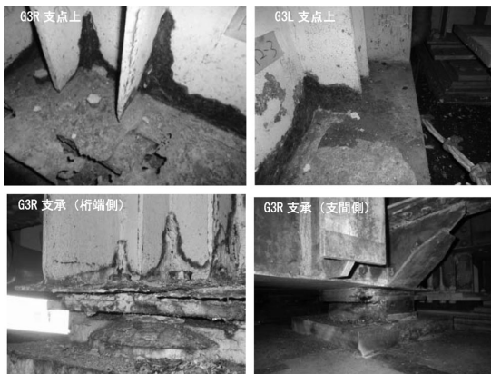
図-4 G3桁端部腐食損傷状況
