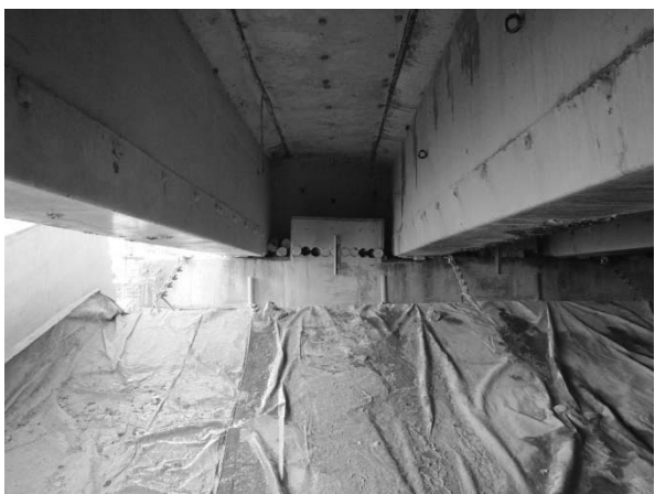
図-15 ワイヤーソーイング切断箇所 奥の横げた橋脚部
