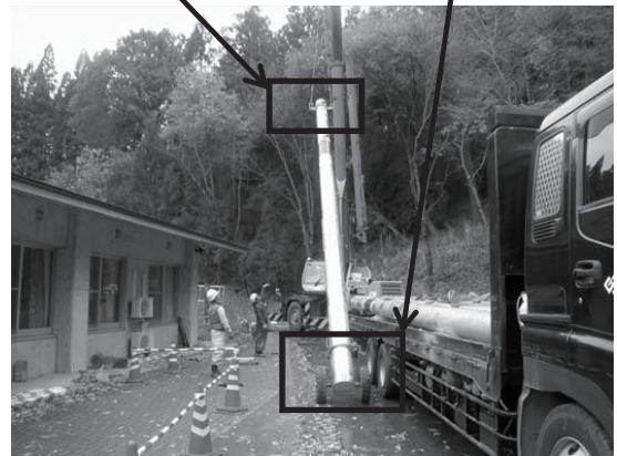
図-4 崩壊土砂防止柵支柱建込み状況
