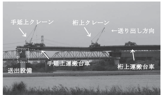
図-5 橋脚上設備の運搬、設置状況
