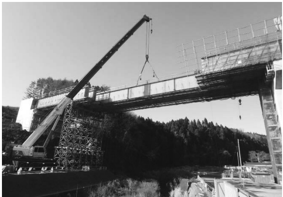
図-10 落とし込み架設状況
