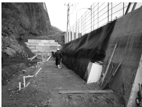
図-5 全体施工状況
