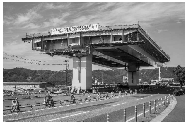
図-11 一括架設完了
