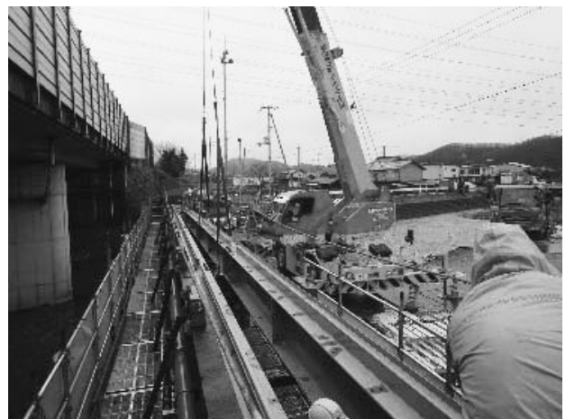
図-3 桁架設状況
