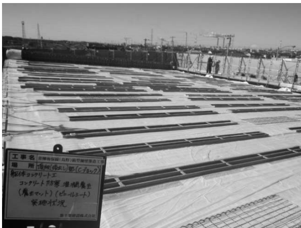
図-5 太陽光熱による密閉養生 (水和熱反応と同等の効果が得られる)
