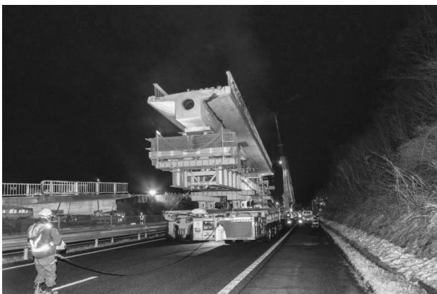
図-9 中央径間運搬状況写真
