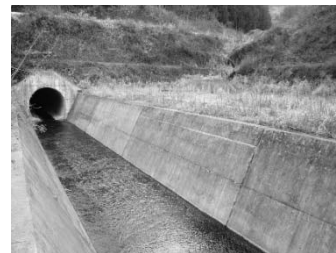
図-2 トンネル入口
