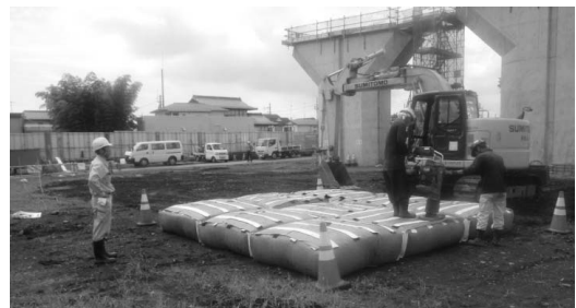
図-3 D・BOX 施工状況
