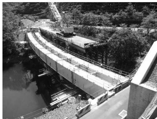
図-15 桁架設完了
