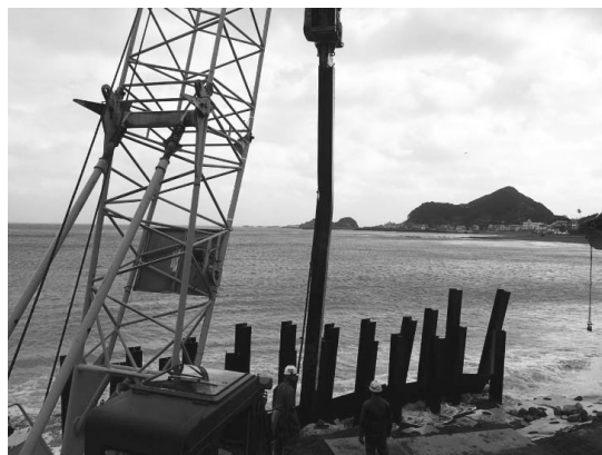
図-6 仮締切り工撤去状況
