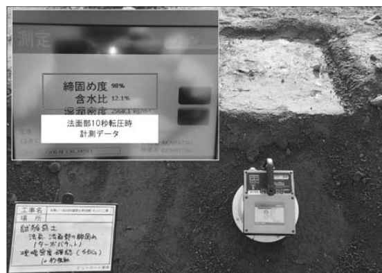
図-6 SDG による計測状況
