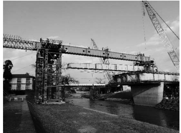
図-4 桁送り出し状況（全景）
