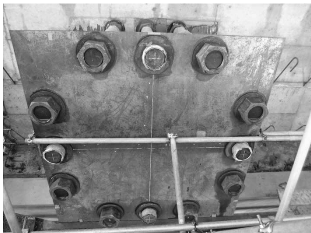
図-4 アンカーボルト間隔保持材
