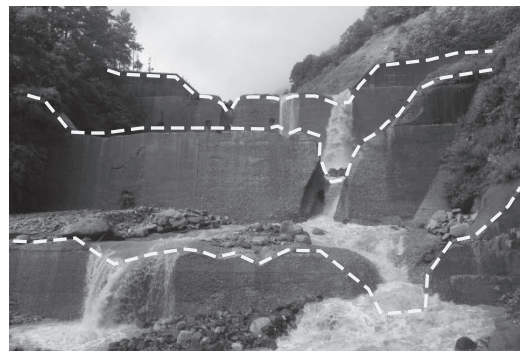
図-1 浦川砂防堰堤 摩耗・損傷状況
