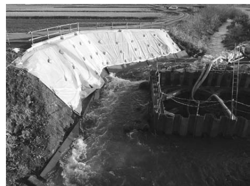
図-6 河川増水時の状況（仮設完了）
