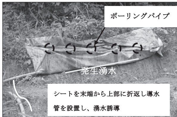
図-6 発生湧水誘導状況
