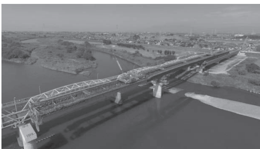
図-7 先端支持状況（上）送り出し状況（下）
