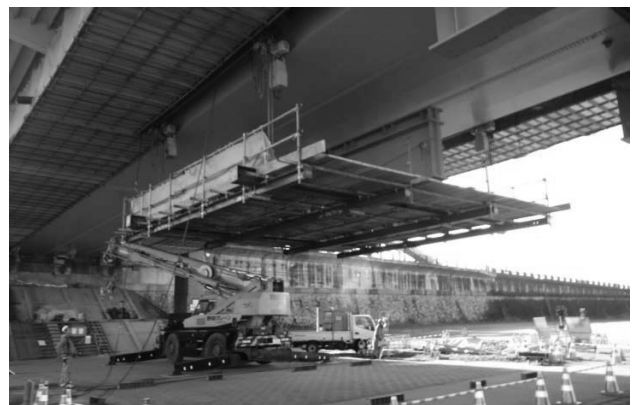
図-9 仮受ブラケット荷上げ状況
