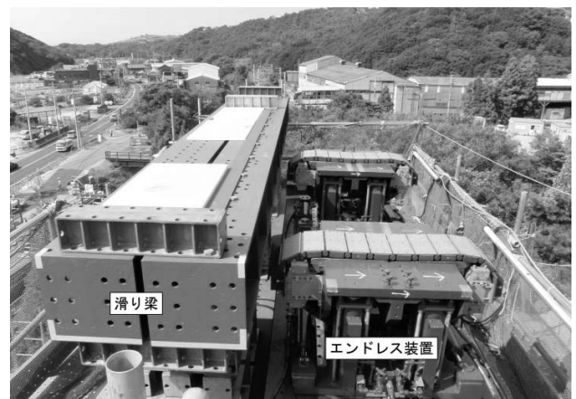
図-4 到達側設備
