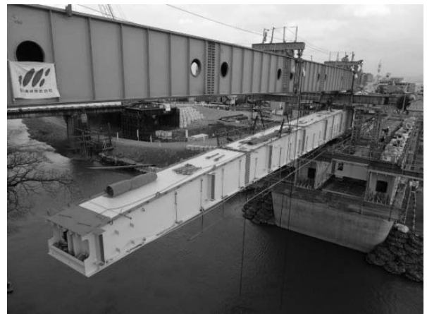
図-5 桁送り出し状況（近景）
