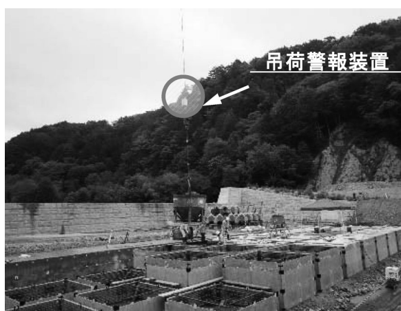
図-14 コンクリート打設状況
