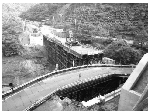
図-11 架設用仮橋完成
