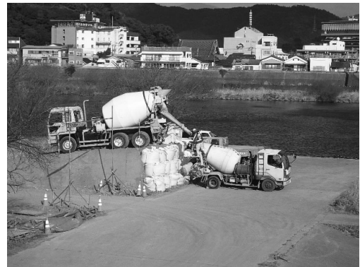
図-3 積替え用の盛土
