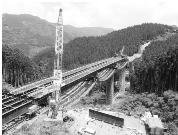
図-1 架設状況全景
