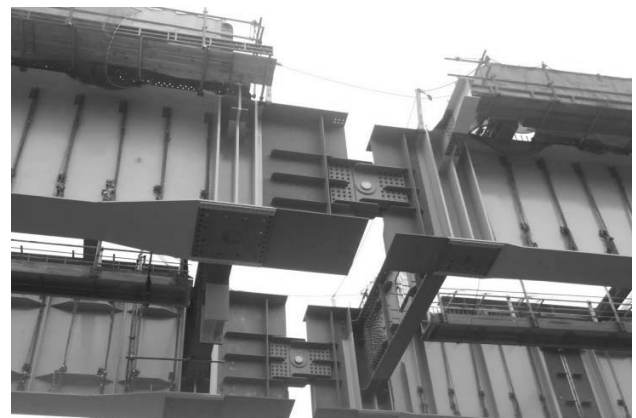
図-6 重連式送り出し架設②
