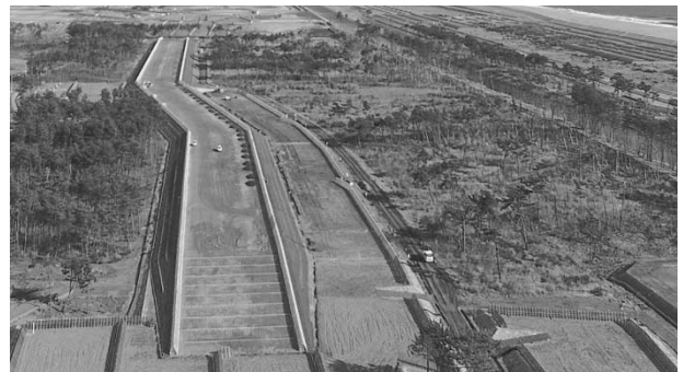
図-1 盛土完成写真
