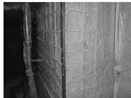
図-7 面木の設置
