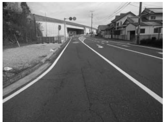
図-2 着手前現況
