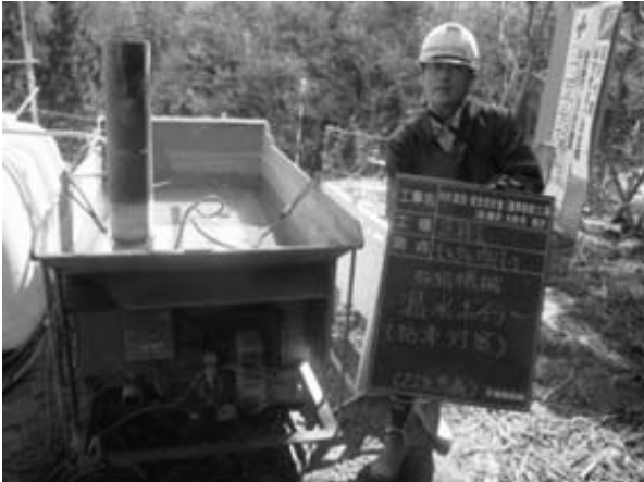
図-7 温水ボイラー設置状況
