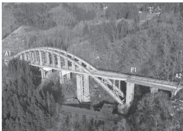
図-2 架設完了全景
