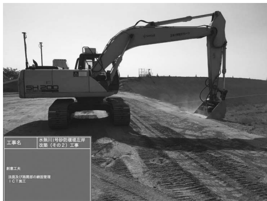
図-8 盛土端部の施工状況
