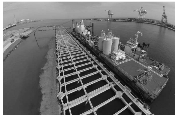
図-5 施工状況（プレミックス船工法）
