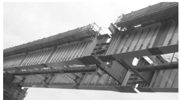
図-5 重連式送り出し架設①
