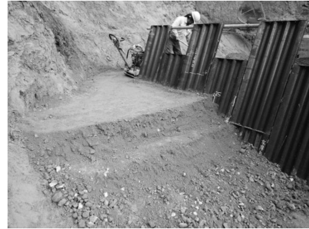
図-7 左岸上流間詰
