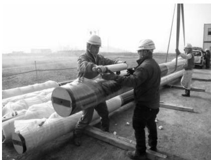
図-2 崩壊土砂支柱上部のシート養生状況
