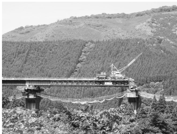
図-2 手延べ機上のトラベラークレーン
