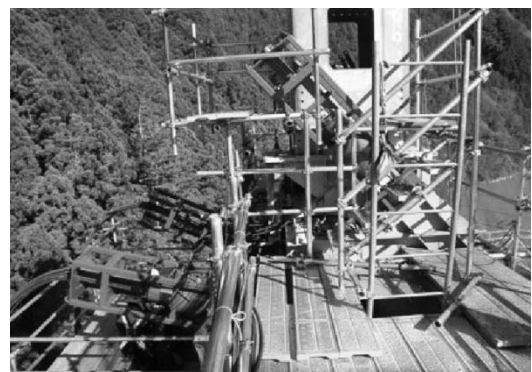
図-6 VSL ジャッキ取付状況
