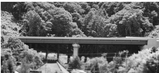
図-1 大沢第二橋
