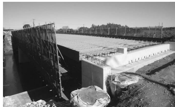
図-6 橋梁全景（架設工事完了後）
