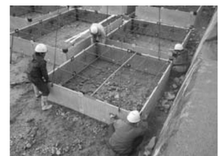
図-12 下段型枠設置状況
