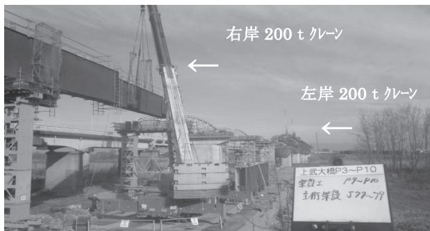
図-10 右岸、左岸同時架設状況
