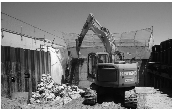
図-4 ブレーカによる取壊し
