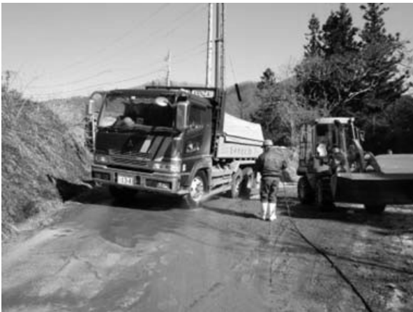
図-8 車両タイヤ洗浄状況
