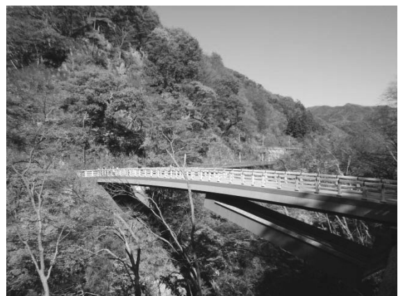
図-6 猿橋全景（完成時）
