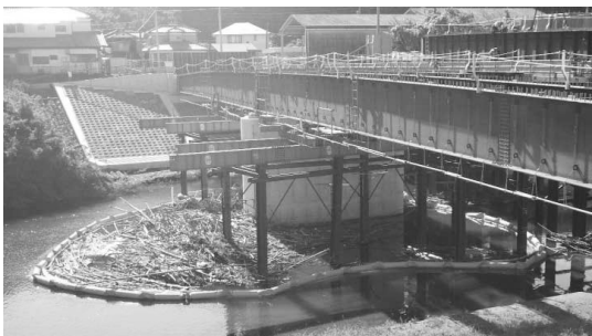
図-4 栈橋設備の杭を利用した杭ベント
