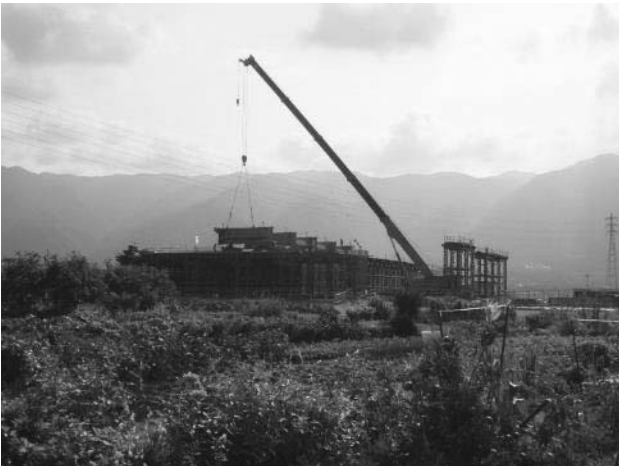
図-10 桁架設
