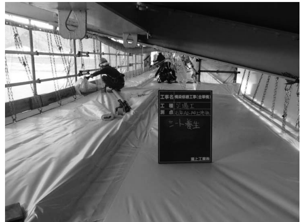
図-13 防滴シート設置状況
