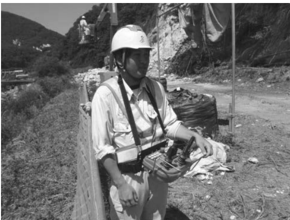
図-9 無線操作者（不整地運搬車）
