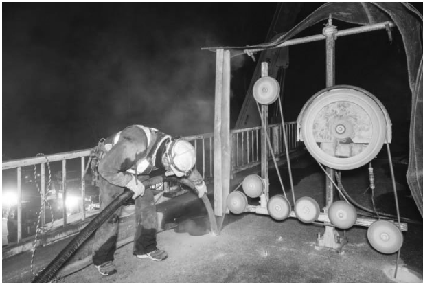
図-8 乾式ワイヤーソー切断状況
