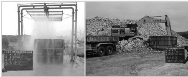
図-3 洗浄（1回目シャワー設備・2回目タンク）
