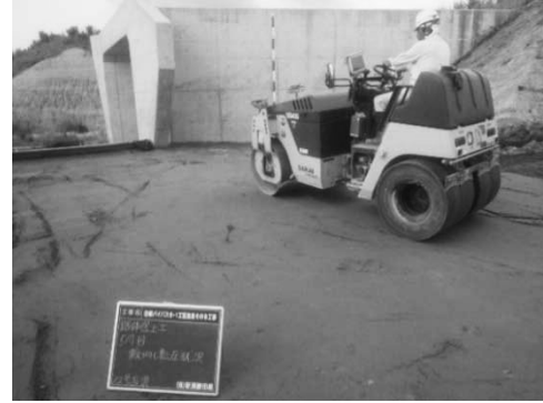
図-5 4 t ローラーによる締固め
