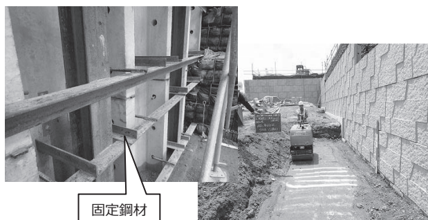
図-5 固定鋼材の設置
