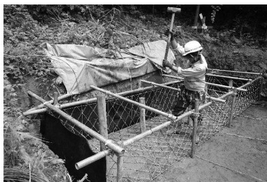
図-7 孔口保護工（ふとん籠）施工状況
