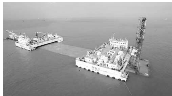
図-5 沈埋函沈設状況
