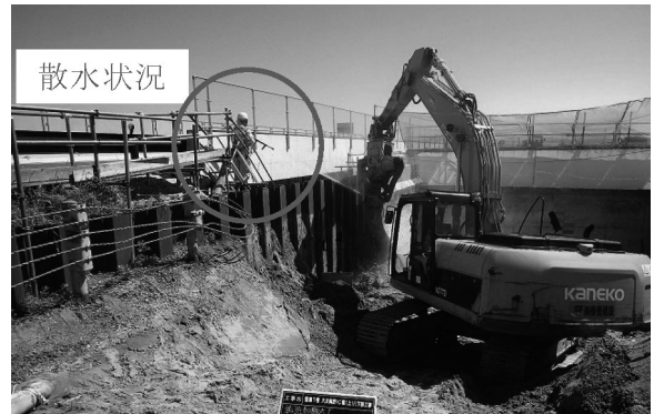
図-5 大割ハサミによる取壊し
