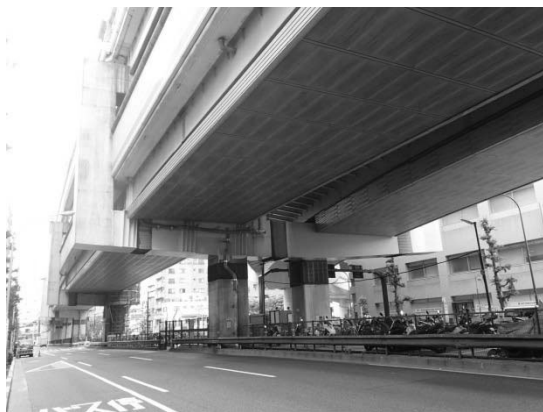
図-1 5号池袋線（板橋工区）
