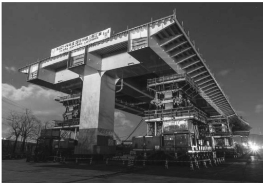
図-1 多軸式特殊台車一括架設状況
