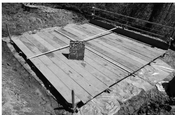
図-4 仮設足場下シート敷設
