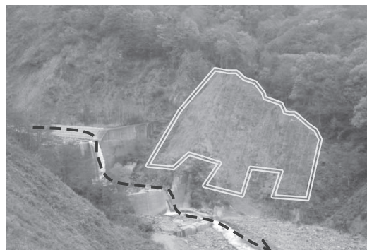
図-2 工事完成時 ※二重線内左岸工区
