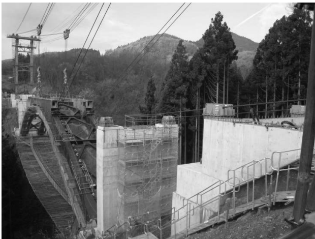
図-6 アーチ部材の斜吊り設備
