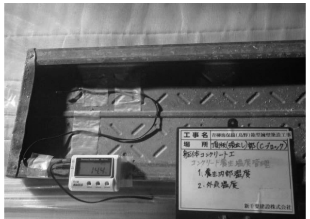
図-6 温度計測管理 (1:養生内温度・2:外気温)
