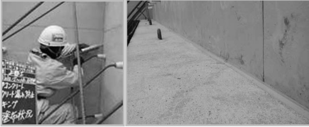
図-8 シリコンコーキング施工
