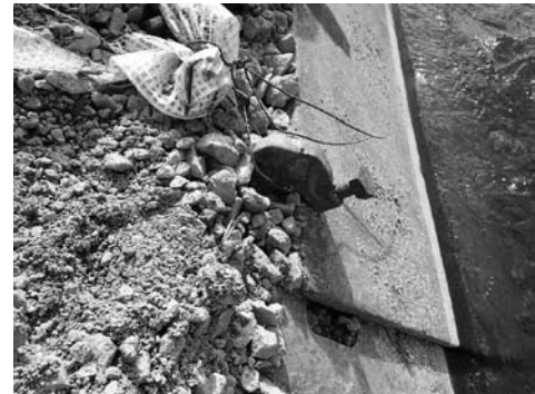
図-4 鉄板の重ね合わせ連結状況
