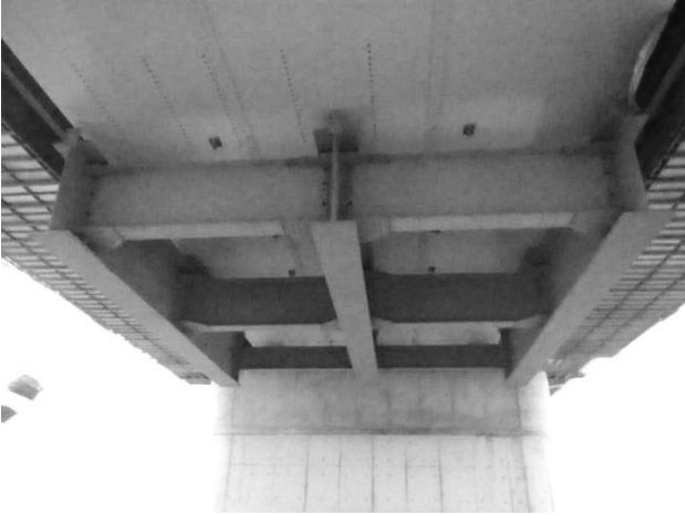
図-6 仮受ブラケット設置状況
