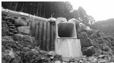
図-7 道路横断部端末完了
