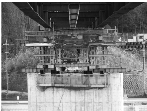
図-2 送出し状況
