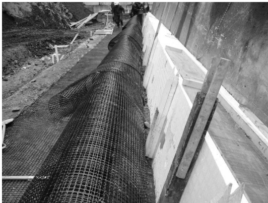
図-4 被り確保状況
