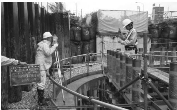
図-5 アンカーボルト計測状況
