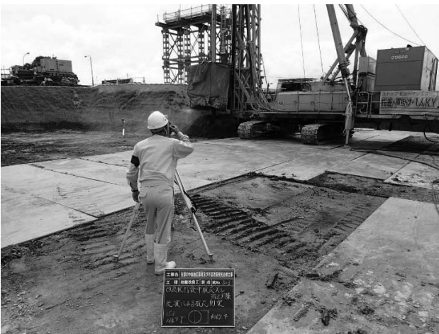
図-2 改良杭施工中の杭位置計測状況
