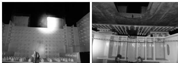
図-6 取替完了状況(左：桁内、右：桁外)
