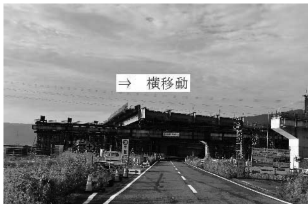
図-3 桁横移動
