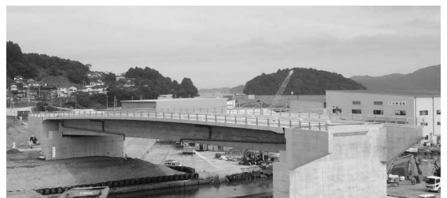
図-8 曙橋（上部工）工事 完成写真
