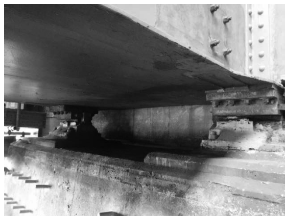
図-1 桁端付近の様子
