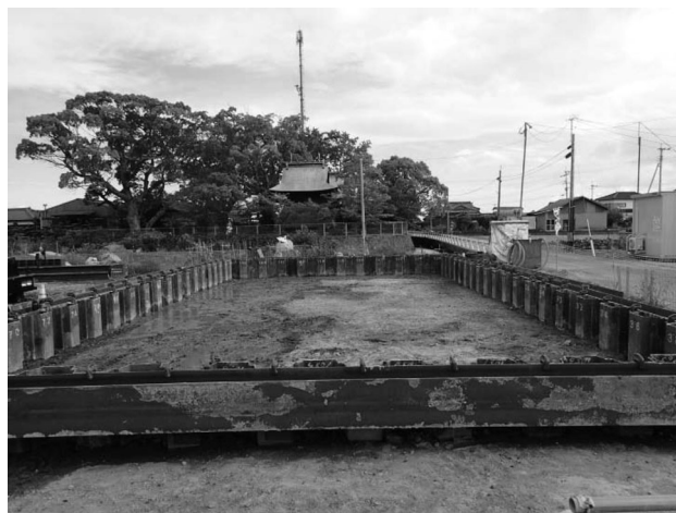
図-4 矢板転倒抑制対策
