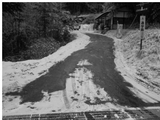
図-6 消雪剤散布後状況
