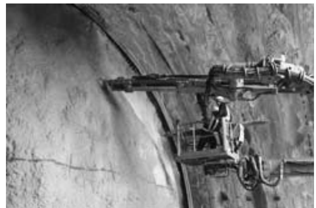
図-2 DRISS 施工状況
