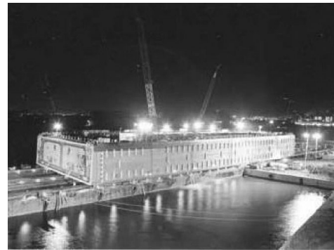
鋼殻出荷状況(エアークャスターによるスキッドアウト方式)
