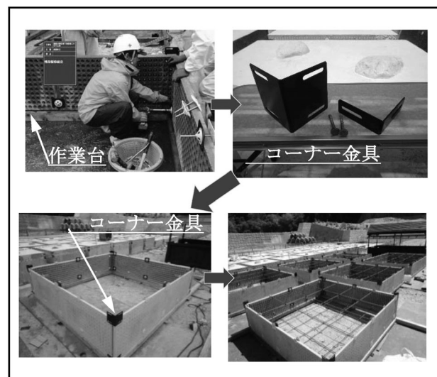
図-6 下段組立状況
