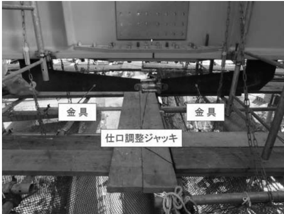
図-8 継手ギャップ調整装置
