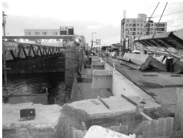
図-16 1次解体施工状況
