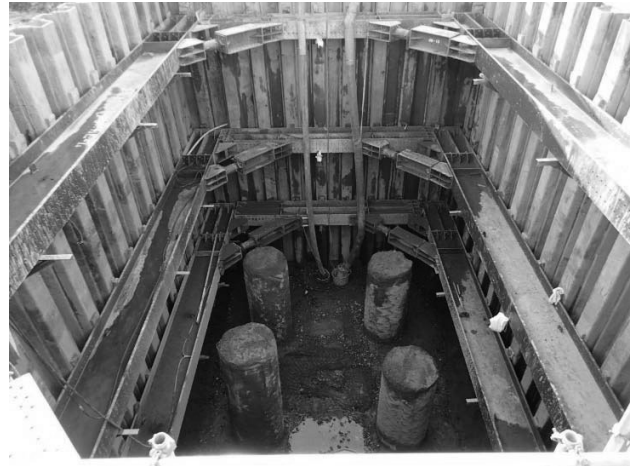
図-3 ヒロセメガビーム設置状況
