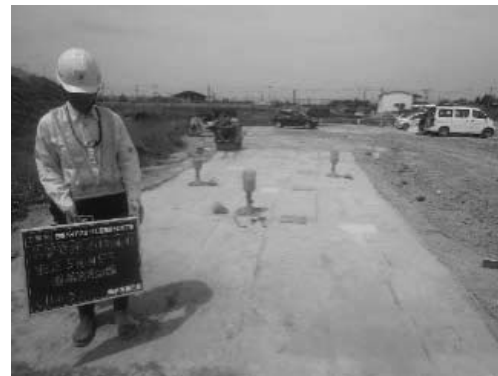
図-2 試験盛土実施
