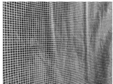
図-5 透明シート（布入り）設置状況
