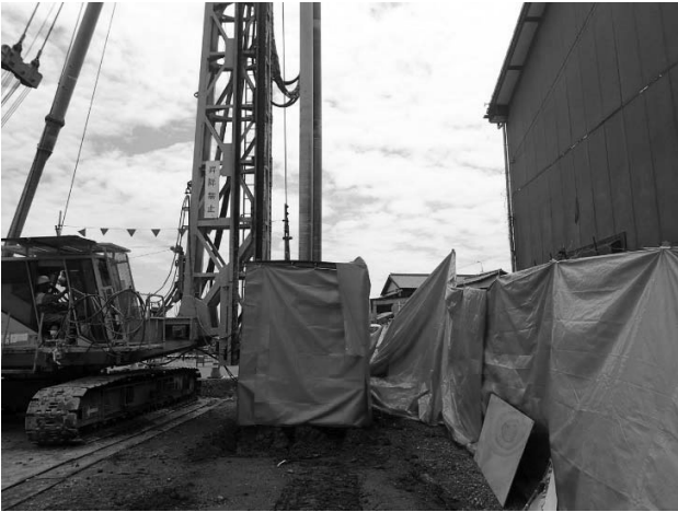
図-1 住宅最近接地盤改良施工
