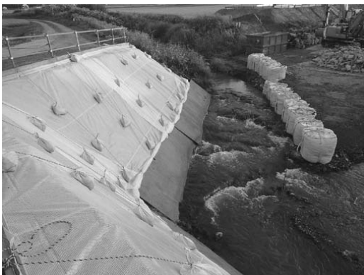
図-3 河川切廻し状況（シート保護）
