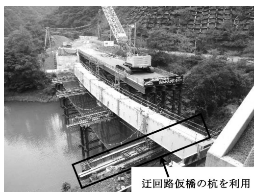
図-12 桁横取り作業前
