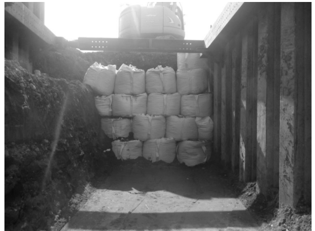
図-10 掘削完了カ所の大型土嚢
