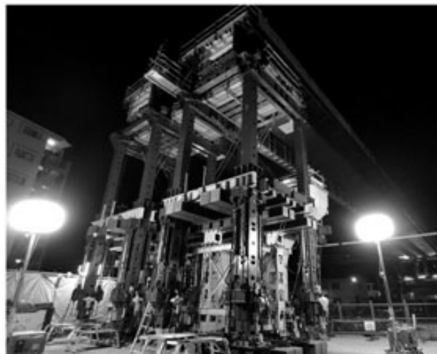
図-4 写真 SHL システム (降下作業状況)
