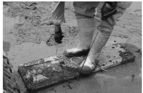
図-5 実工事における作業状況
