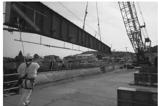
図-3 鋼桁架設状況②
