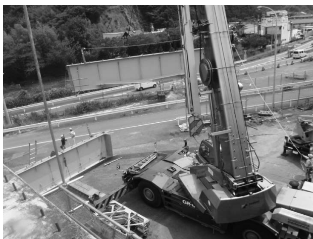
図-2 50t クレーンによる施工状況
