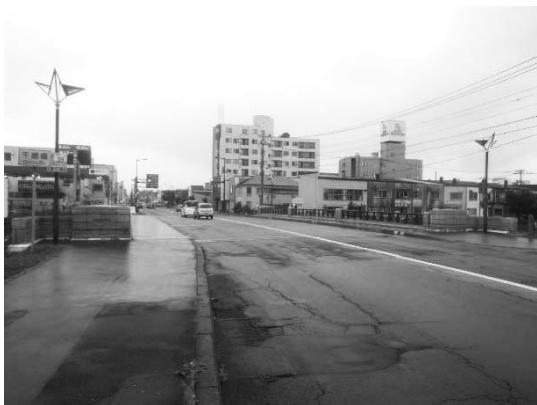
図-4 千歳橋、橋面現況
