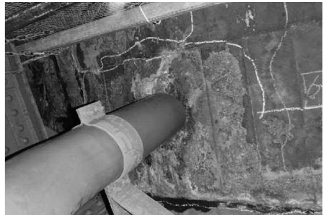
図-1 排水柵部漏水による損傷事例
