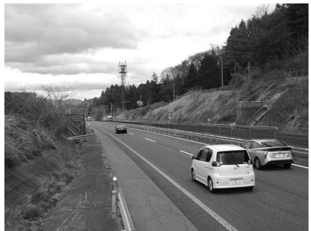
図-11 溝上橋撤去完了写真
