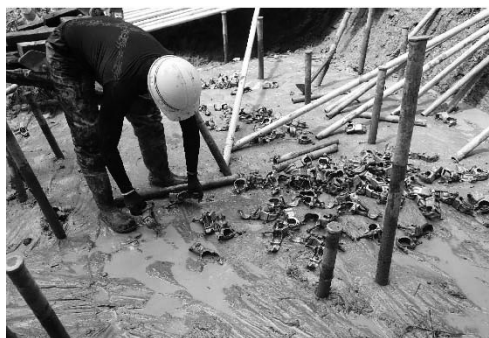
図-5 足場撤去作業状況
