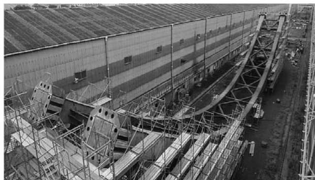
図-3 アーチ部材の倒立一体仮組立
