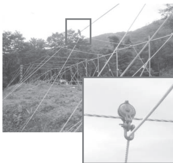
図-8 水平部：接触防止ワイヤー架設+動滑車
