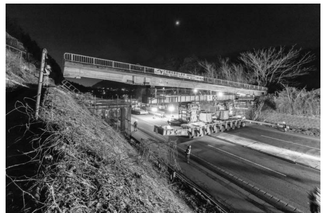
図-7 月夜の平橋撤去状況写真
