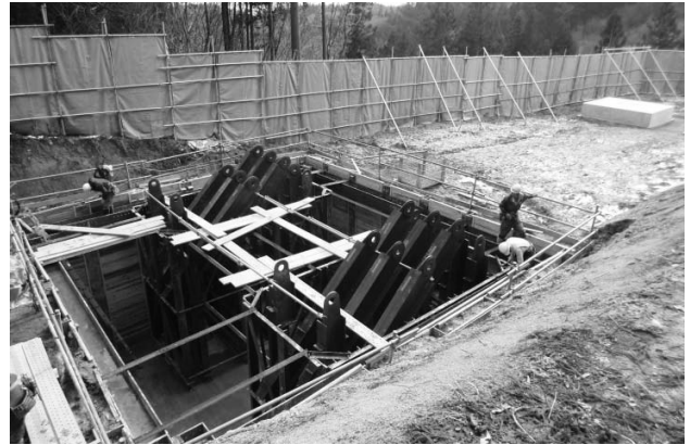
図-7 アンカーフレーム据え付け状況
