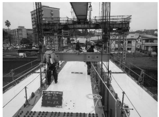
図-6 桁降下状況
