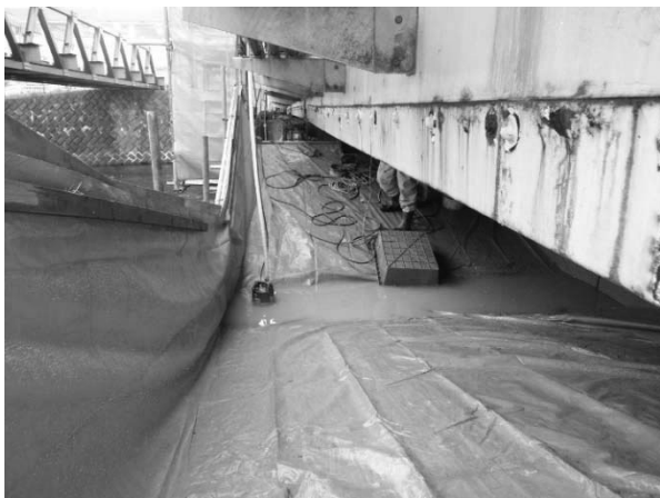
図-14 汚泥水回収状況
