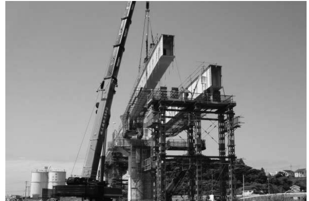
a) 地組立ブロック架設（P3-P5）
