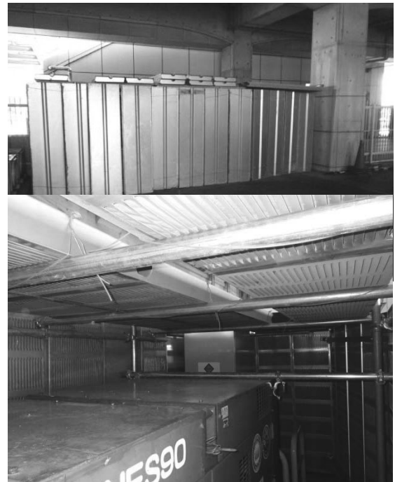
図-7 発電機の吸音板の設置状況
