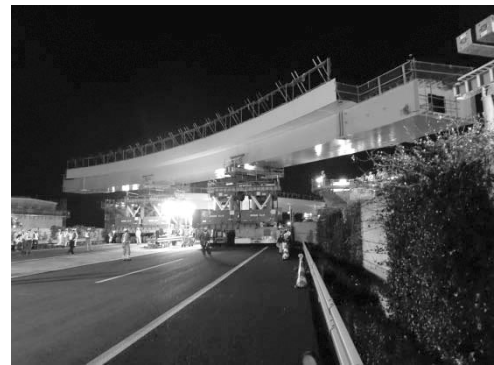
図-2 キャリア架設状況
