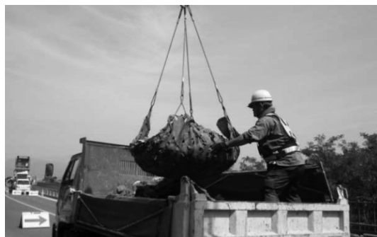
図-3 ワイヤーモックでの土砂積込
