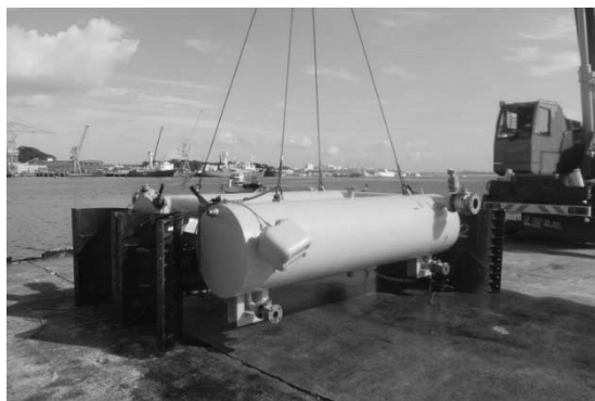
図-2 フローター艀装状況
