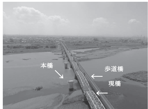
図-2 既設橋と架橋位置
