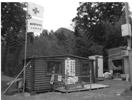
図-13 ログハウス型現場事務所
