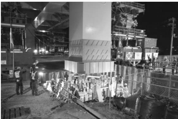
図-9 アンカーボルト挿入状況
