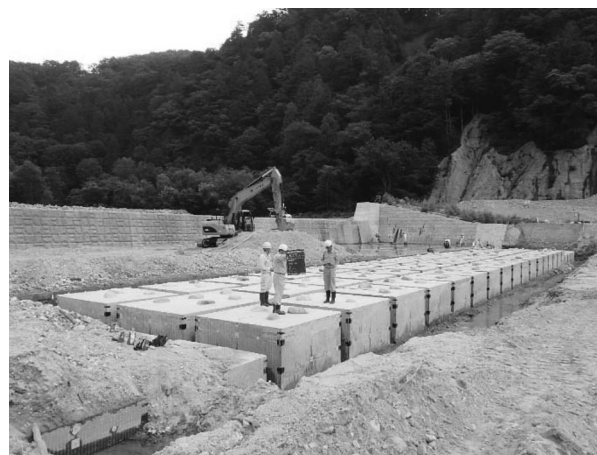
図-15 護床工完了
