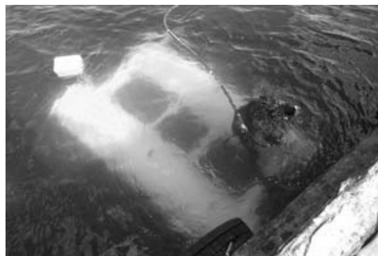
図-4 補強部材曳航状況
