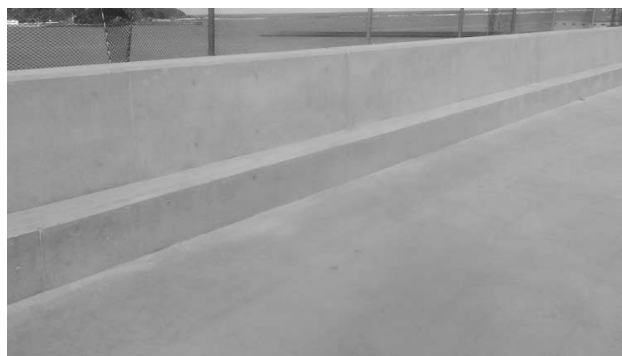
図-10 コンクリート外観
