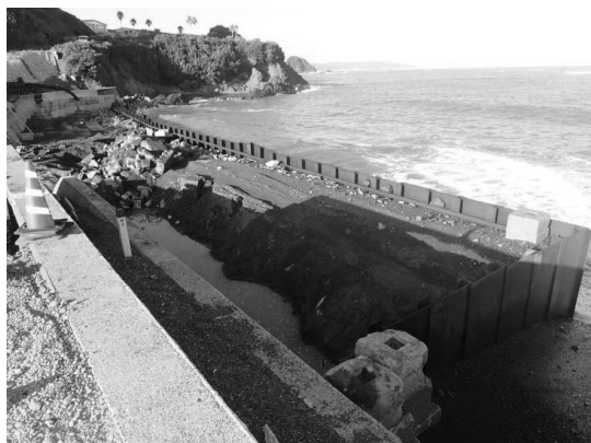
図-4 仮締切り状況
