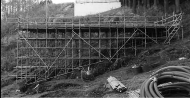
図-3 単管足場による構台設置
