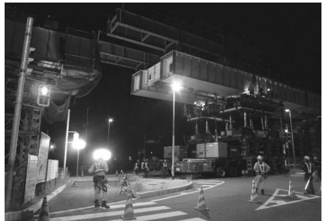
図-5 送り出し架設状況
