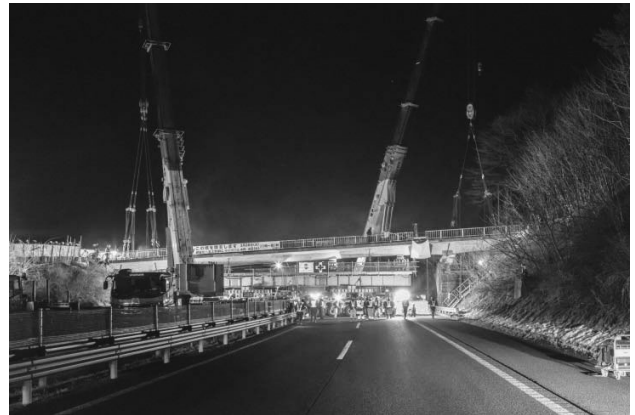
図-10 溝上橋撤去状況写真
