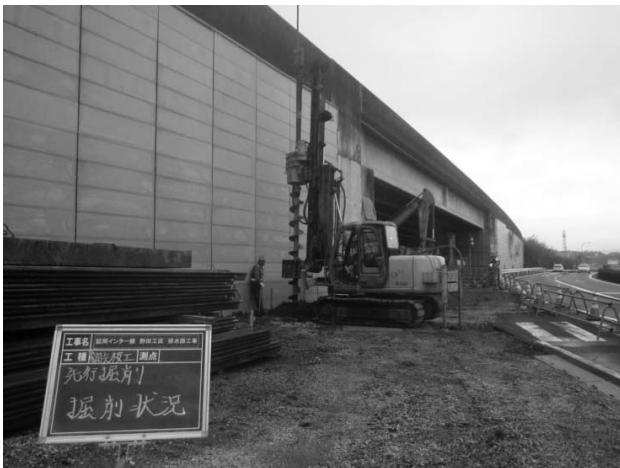
図-6 マルスドライバーによる先行掘削
