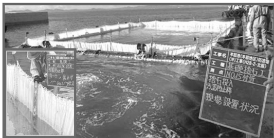
図-4 汚濁防止枠嵩上
