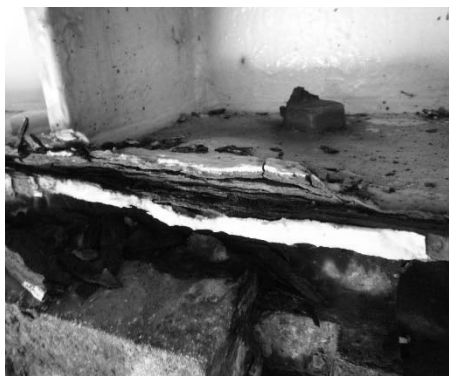
図-1 母材腐食写真
