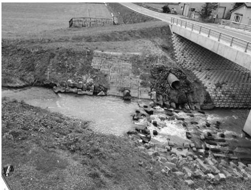
図-1 既設護岸現況
