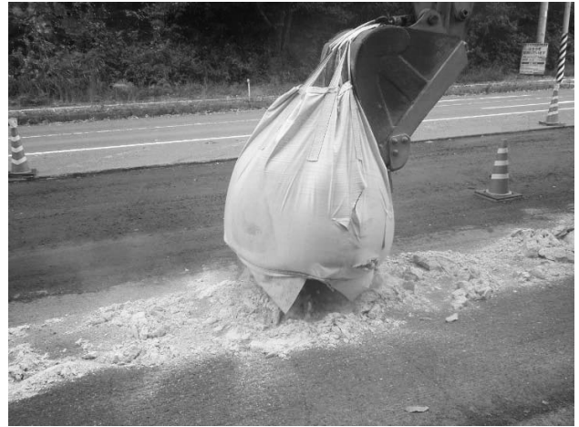
図-5 セメント散布状況
