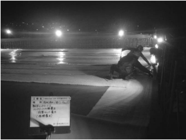
図-4 密閉養生施工（左：養生マット施工・右ビニールシート施工）
