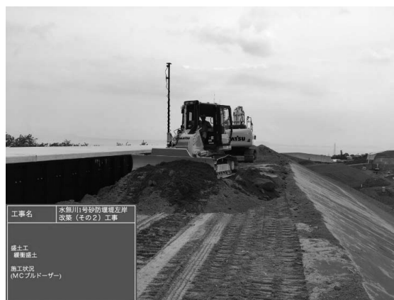
図-4 緩衝盛土 ICT 施工状況
