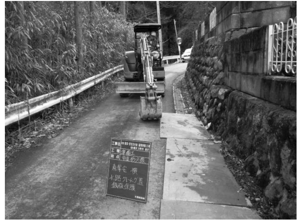
図-9 鋼板布設養生状況
