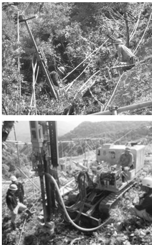
図-7 上：吊り下げ式削孔機（スカイドリル） 下：クローラー式ボーリングマシン
