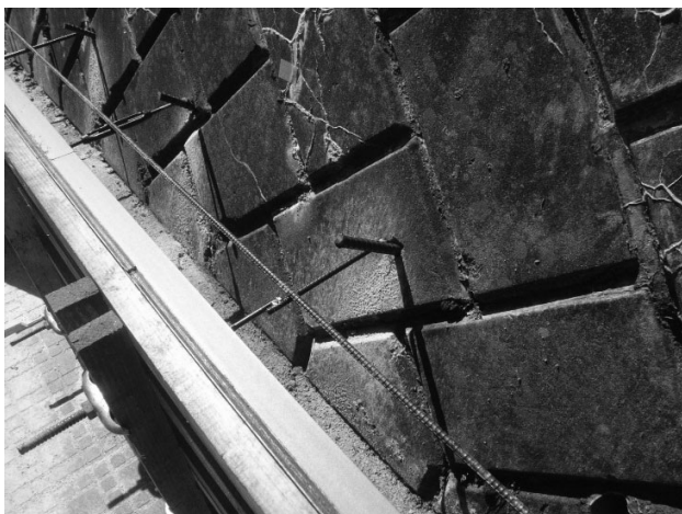
図-4 用心鉄筋設置
