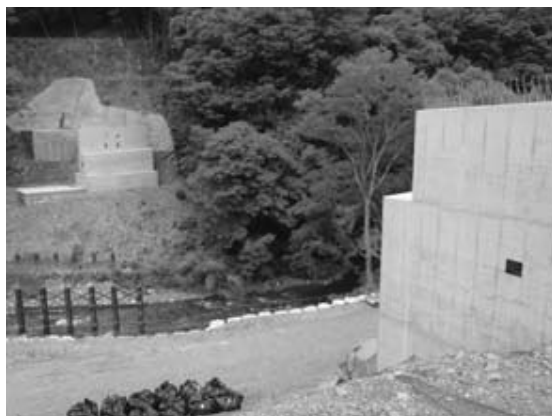
図-1 着手前状況
