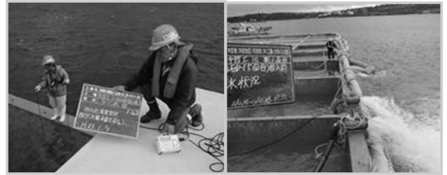
図-6 排水前濁度測定・排水
