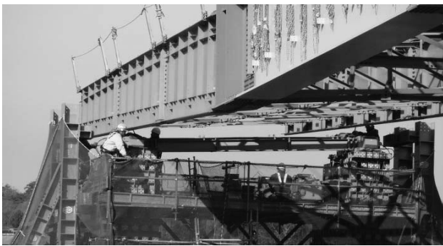
図-8 鉛直上方に上げ越した手延べ機②
