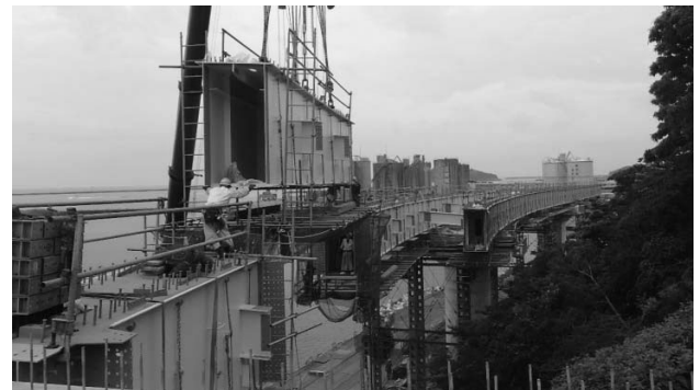
b) 単材ブロック架設（P5-A2）（落とし込み）
