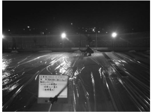
図-4 密閉養生施工（左：養生マット施工・右ビニールシート施工）
