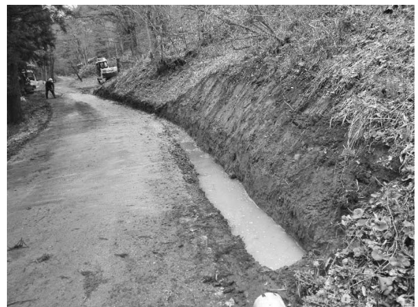
図-1 土側溝設置
