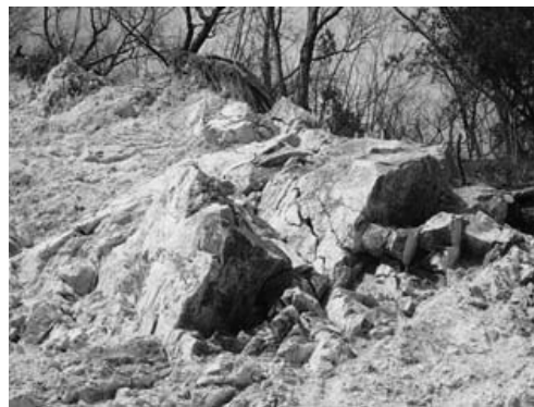
図-2 斜面状況（亀裂大）
