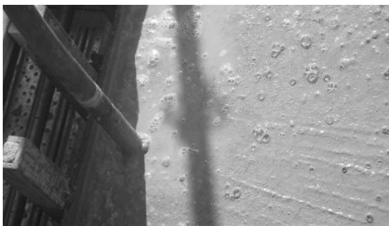
図-3 排出された気泡・ブリーディング水
