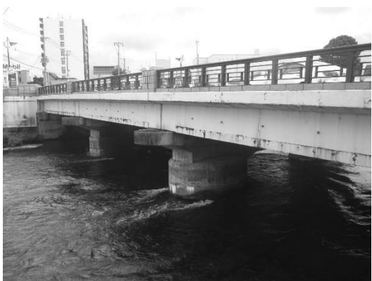
図-5 千歳橋、下流側側面現況
