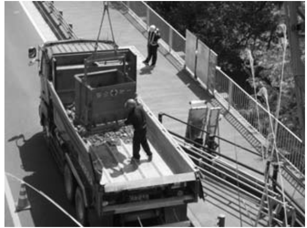
図-10 底開き式バケツトによる積込状況
