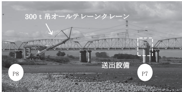
図-9 P7脚上設備の先行組立
