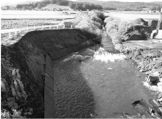
図-2 河川切廻し状況（鉄板養生）
