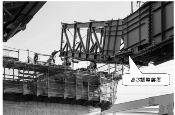
図-11 たわみ処理状況
