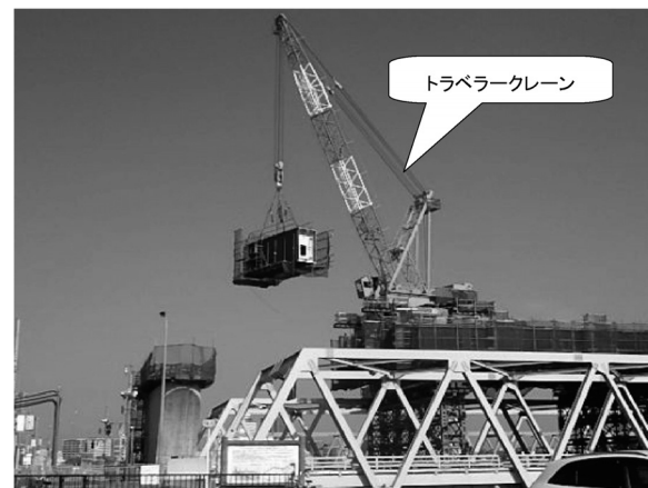
図-5 トラベラークレーン架設状況
