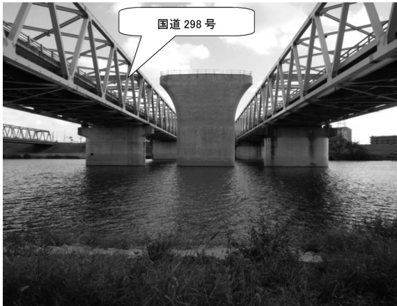
図-3 江戸川河川内の橋脚と国道298号
