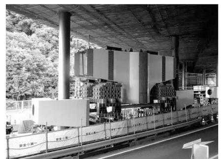
図-7 鋼製梁横取り・縦取り完了
