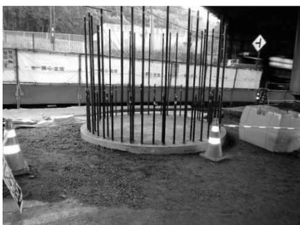
図-5 RC柱1次施工完了
