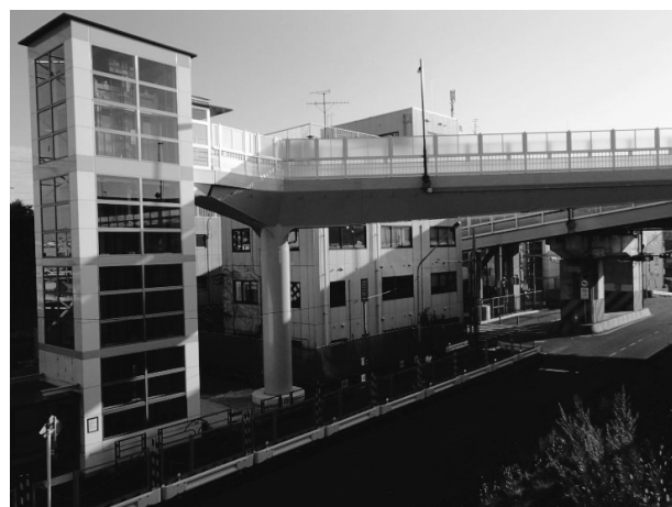
図-12 連絡橋完成（左はエレベーター昇降施設）
