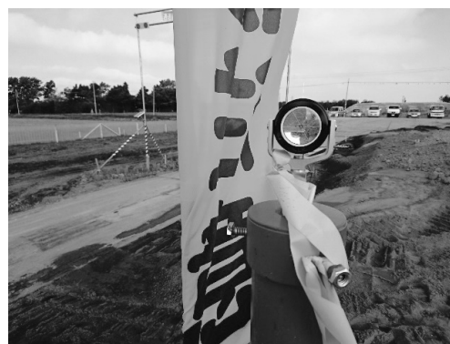
図-4 蓋に取付けたプリズム
