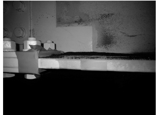
図-13 バイパス材跡補修溶射完了
