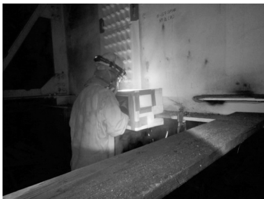
図-12 バイパス材跡補修溶射状況
