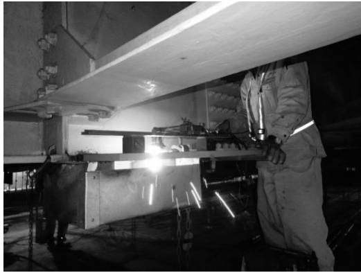
図-10 レール装着による切断
