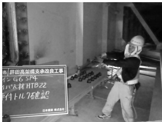
図-4 バイパス材連結板トルク確認
