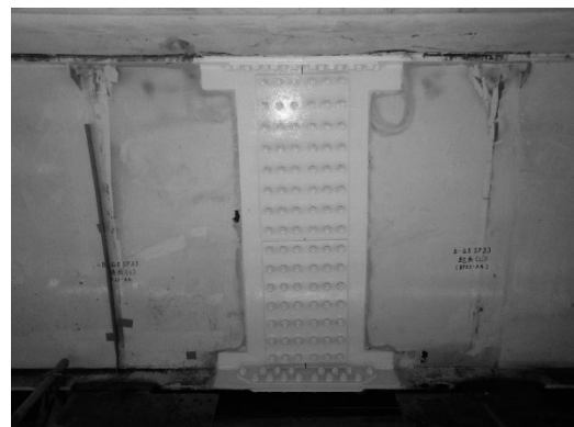
図-14 連結板取替完了
