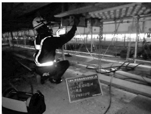
図-3 超音波探傷試験実施
