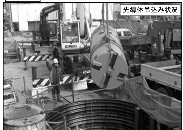
図-4 推進工施工状況
