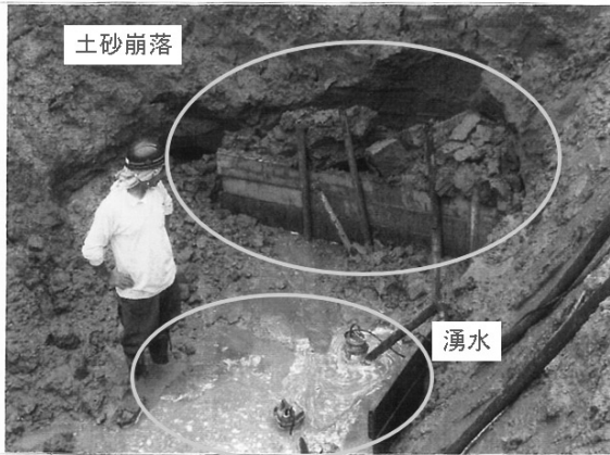
図-2 湧水状況（隣接工事施工時）
