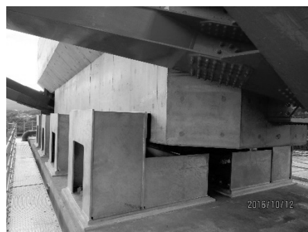
図-12 変位制限装置完成
