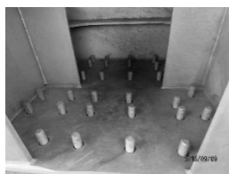
図-11 アンカーボルト配置
