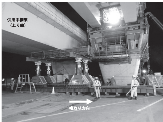
図-5 後方側降下装置横取り状況写真
