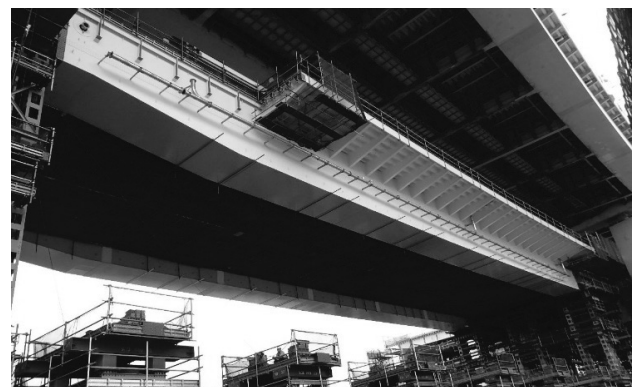
図-5 P8～P7間一括吊上げ架設完了
