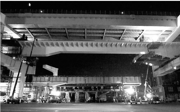
図-10 多軸台車よりの吊上げ架設（主桁単体）
