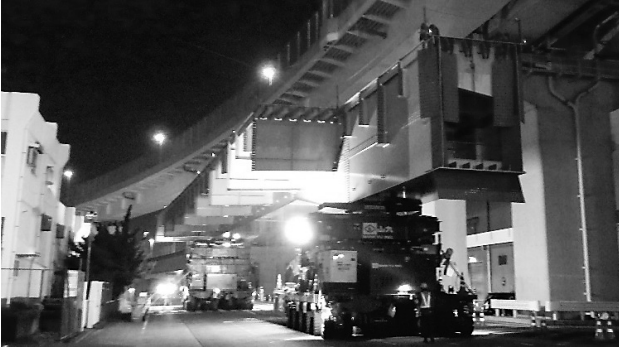
図-9 多軸台車による桁運搬（地組ヤード）
