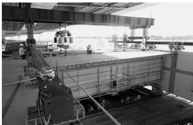
図-3 門型吊上げ設備による中床版吊上げ
