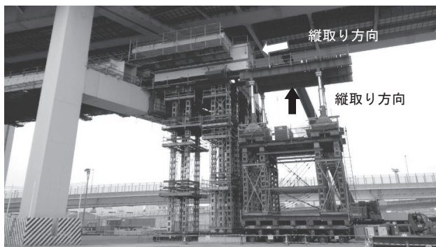
図-2 主桁リフトアップおよび縦取り（G1桁）
