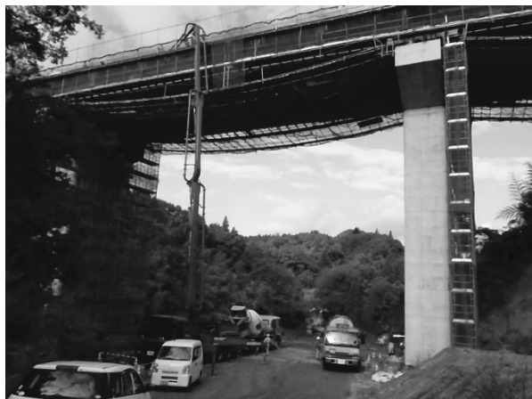
図-4 床版コンクリート打設状況
