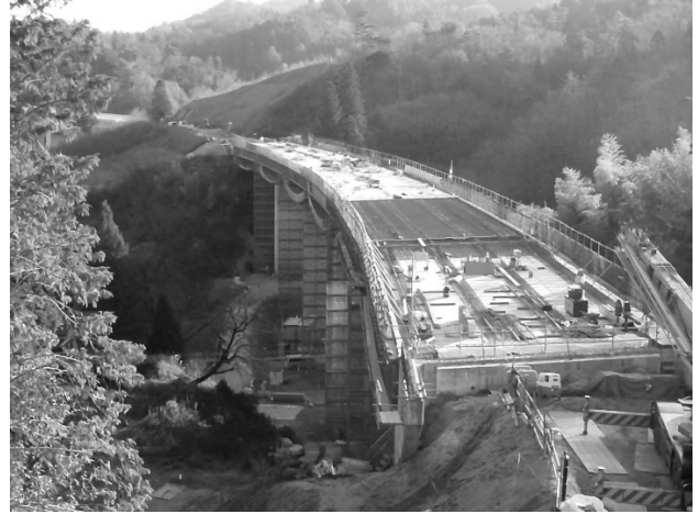
図-8 現在の布川大橋（施工状況）
