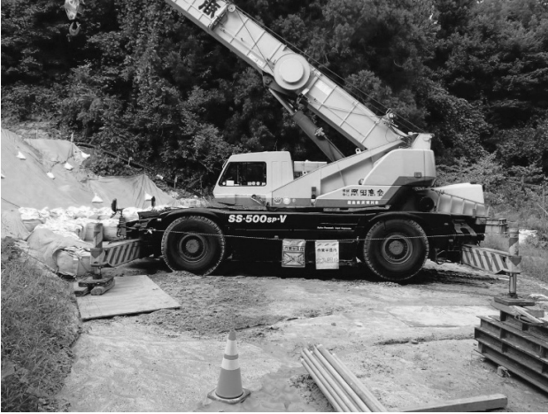
図-7 クレーン作業状況（P 5 橋脚付近）
