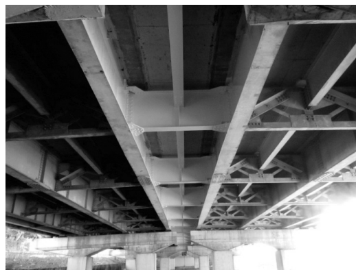
図-13 作草部高架橋完了写真（橋梁下より）
