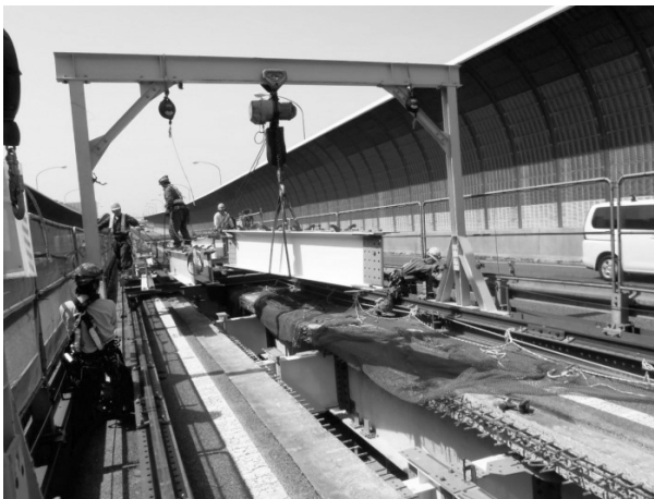
図-7 縦桁架設状況
