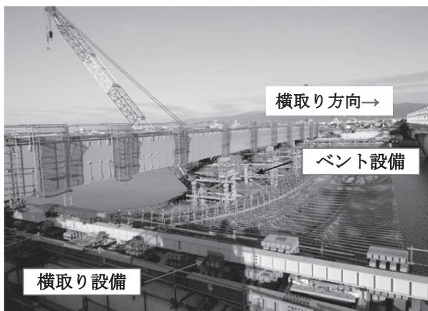
図-3 鋼桁横取り状況
