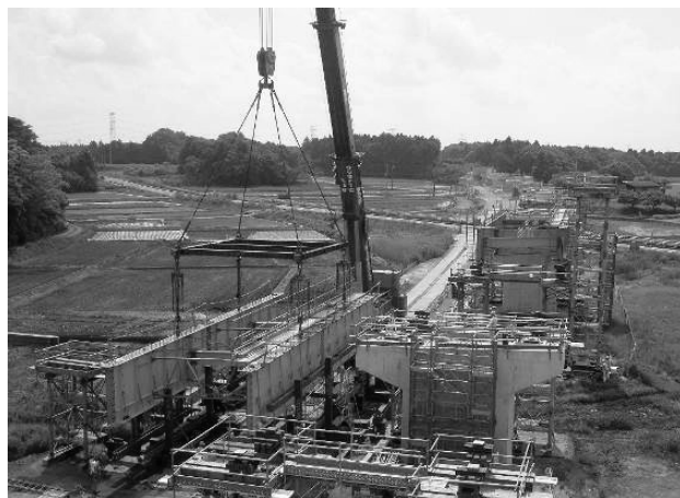
図-3 地組立状況
