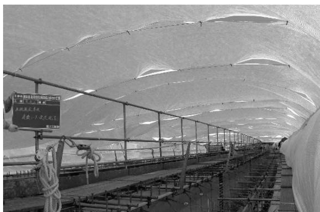
図-4 遮熱ネット設置状況
