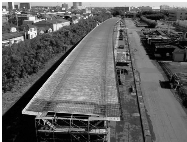
図-6 仮組立状況
