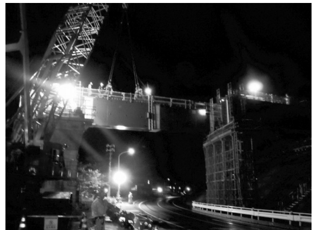
図-7 国道上夜間架設状況
