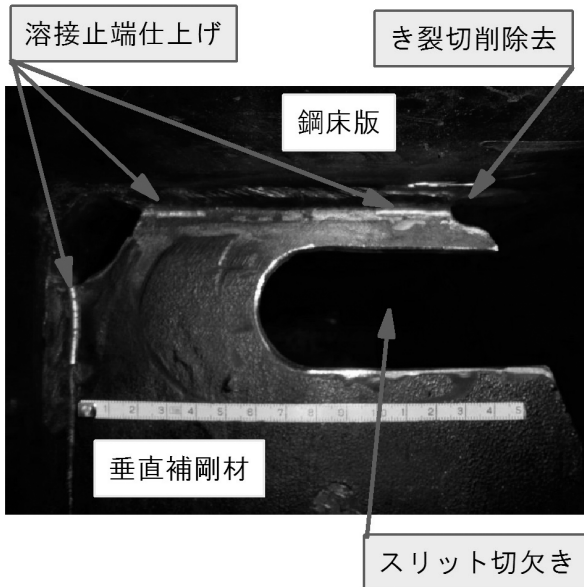
図-10 補修完了写真
