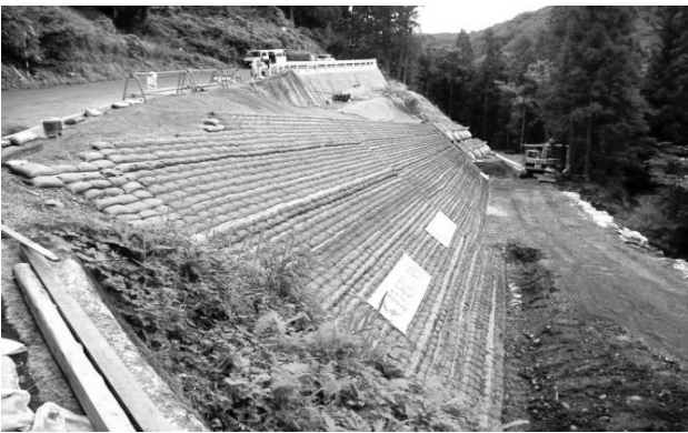
図-10 補強盛土工完了
