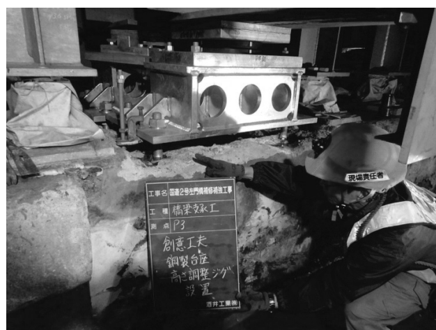
図-4 鋼製支承台座仮固定状況
