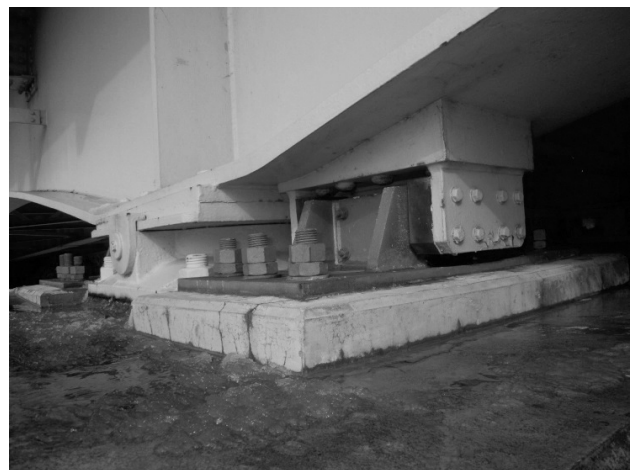
図-2 既設TYPE-A支承
