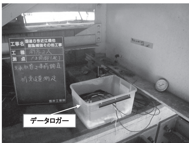
図-4 データロガー設置状況
