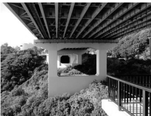
図-1 孫崎高架橋
