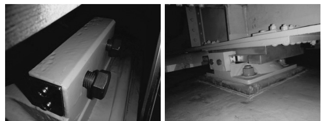
図-8 ステンレス板取付状況 図-9 補修後の支承
