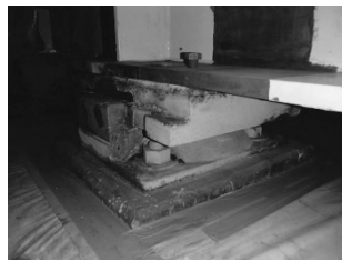
図-2 補修前の支承
