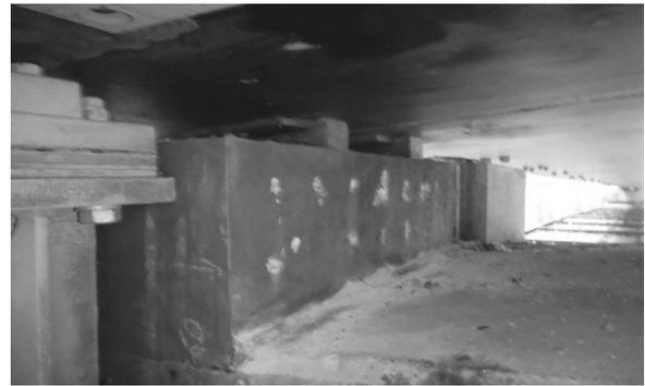
図-2 箱桁の桁下部削孔完了
