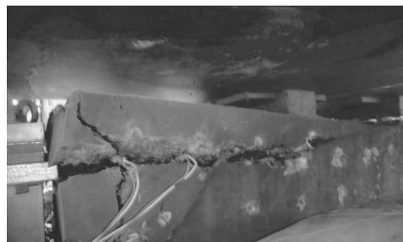
図-4 箱桁の桁下部破碎後
