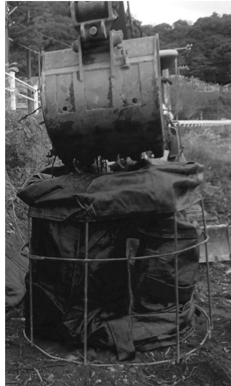
図-2 大型土嚢作製器使用状況
