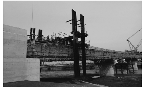
図-3 H鋼杭の運搬状況
