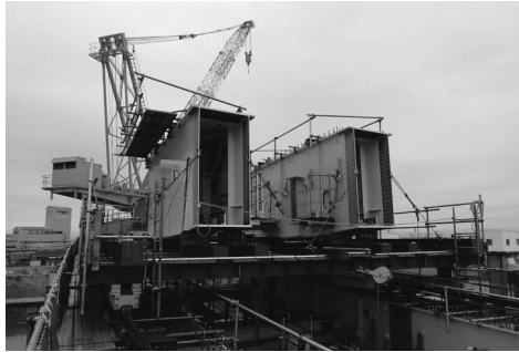
図-2 主桁の運搬状況
