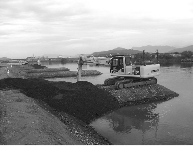
図-2 1号機掘削状況
