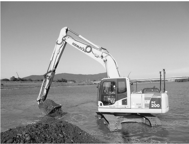
図-3 2号機掘削状況
