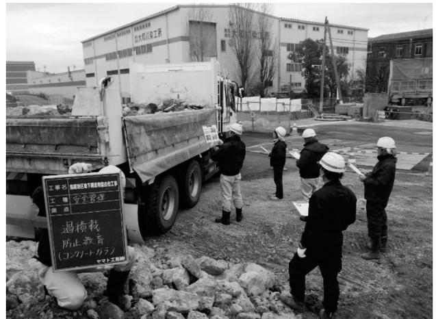
図-6 積込確認（コンクリート殻-荷台枠より20cm）
